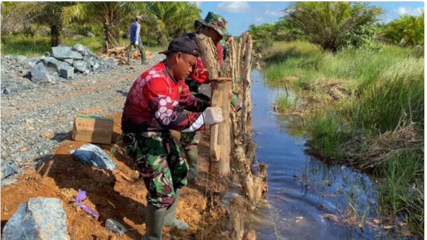
"Kayu Galam" Potensial Untuk Landasan Pemasangan Pondasi
